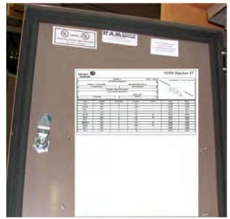
FIG. 3-1 – TERMINATION CHART INSIDE ENCLOSURE DOOR
