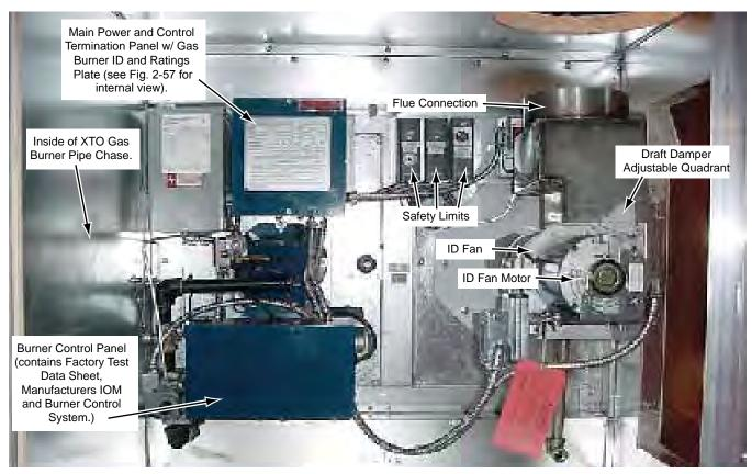
FIG. 2-56 – GAS BURNER COMPONENT LOCATIONS
