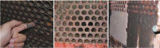
因此在循环冷却水系统普遍都采用了化学水质稳定剂或电子处理仪的水处理方法的情况下，在运行了一段时间后还是要打开冷凝器端盖进行人工捅刷清洗，捅刷掉列管内表面的粘泥、水垢、锈蚀物等的混合物。
