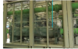
에너지 효율적이며 신뢰할 수 있는 YK 냉동기는 series counter flow로 구성되어 있습니다.
