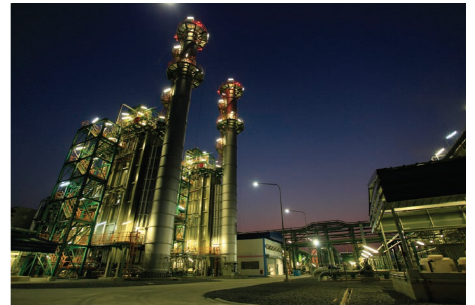
존슨컨트롤즈社의 YD 냉동기는 태국 CCGT Cogen 발전소의 Navanakorn Electric Co. Ltd.의 GTIAC 요구 사항을 충족시키는 냉동 용량을 제공합니다.
