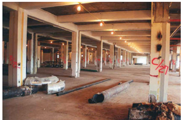
解体・廃棄のプログラムにおいて、ウェッジ1の全ての物資が取り除かれ、830万パウンド（約377万kg）のがれき物のうち70%がリサイクルされました。
